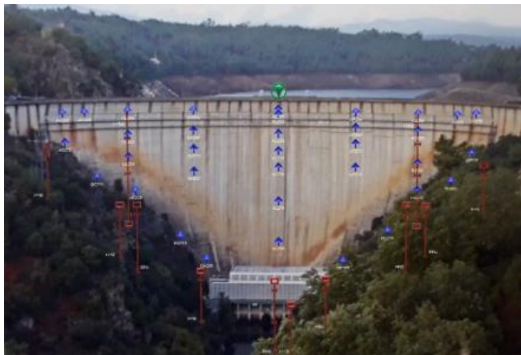
Fig. 1: Representação, num ambiente de realidade aumentada, dos sensores e dispositivos de medição destinados à determinação de deslocamentos horizontais na estrutura da barragem
